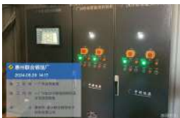
中央空调节能改造
